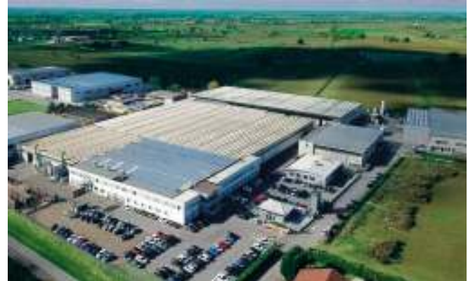
Рис. 1. Главный офис и фабрика Campitello.
